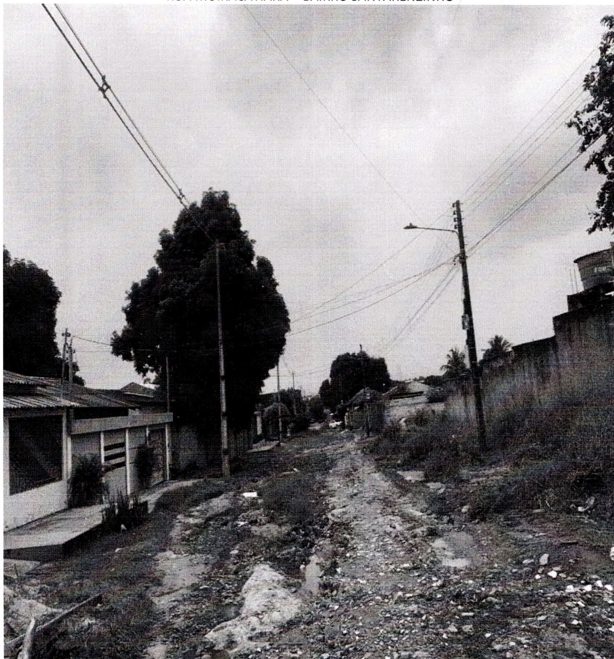
RUA MUIRACATIARA – BAIRRO SANTARENZINHO
